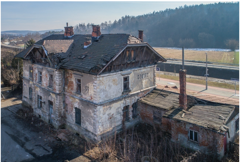
Ryc. 25. Stacja Czudec, widok od strony podjazdu – stan z lutego 2019 r.
