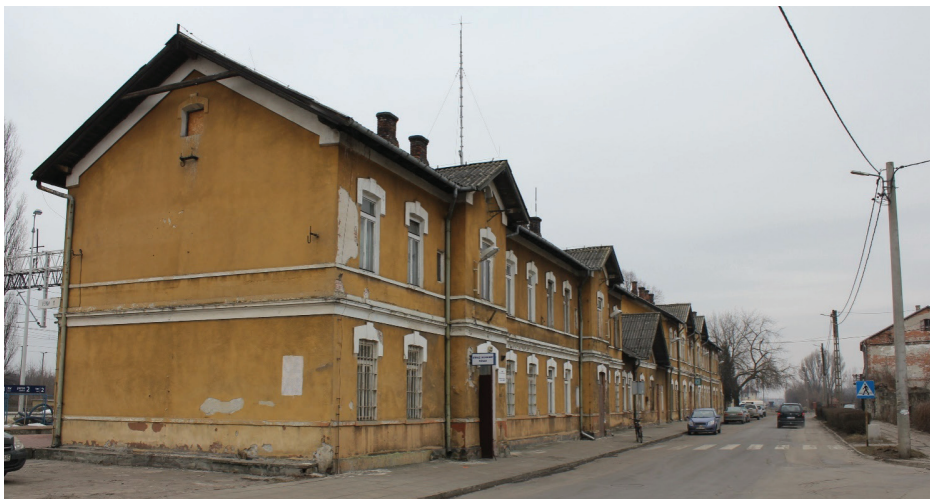
Ryc. 3. Stacja Rozwadów – stan obecny
