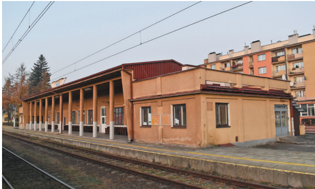
Ryc. 31. Jasło – budynek dworca od strony torów, rok 2018
