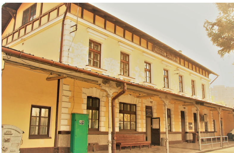
Ryc. 20. Rzeszów Staroniwa, widok od strony torów – stan współczesny
