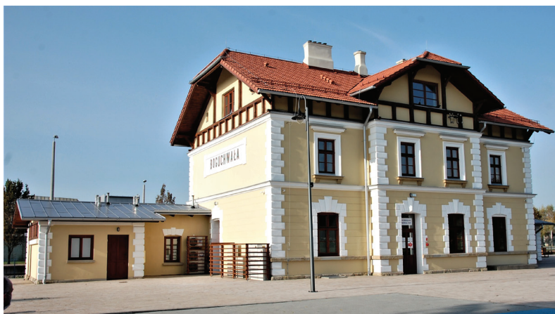
Ryc. 23. Stacja Boguchwała – widok od strony podjazdu
