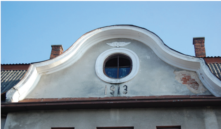
Ryc. 7b. Detal – widoczna data rozbudowy dworca
