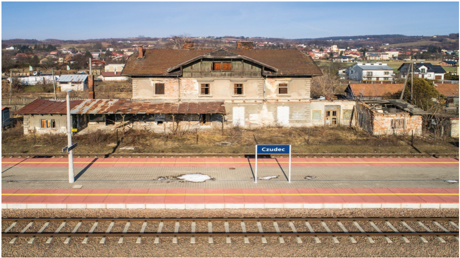
Ryc. 24. Stacja Czudec, widok od strony torów – stan z lutego 2019 r.
